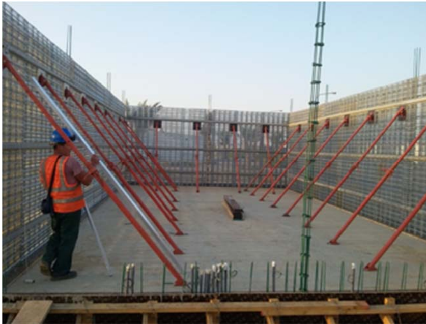
Des étais tire-pousse ou équivalents sont fixés sur les panneaux au niveau des supports horizontaux et au sol, espacés tous les 3 m au maximum.
