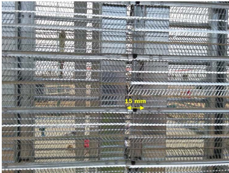
Figure 3 : Recouvrement entre deux panneaux COFFOR
